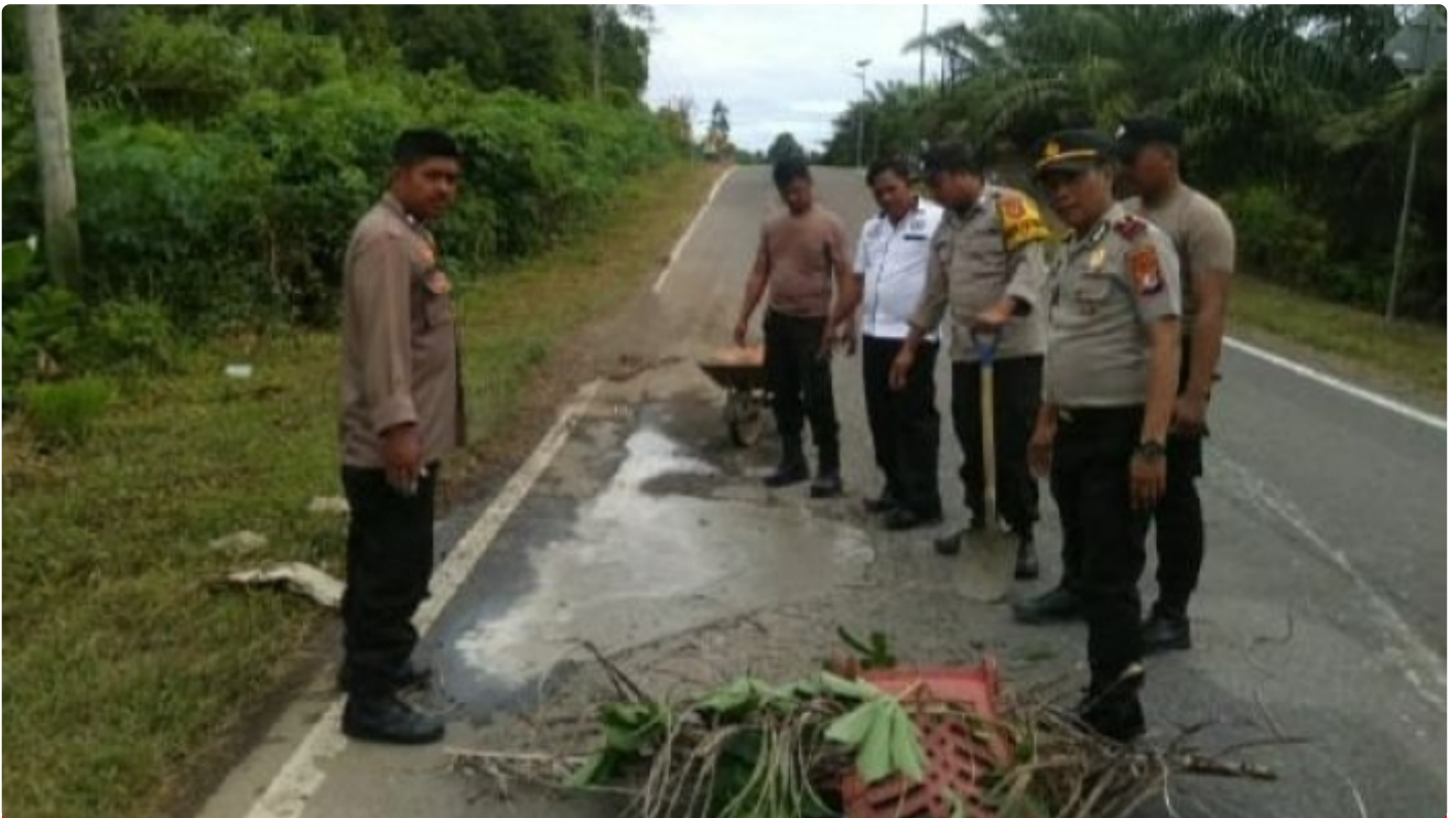
Kapolsek Pangale IPDA Syaiful meninjau langsung jalannya penambalan jalan berlubang
